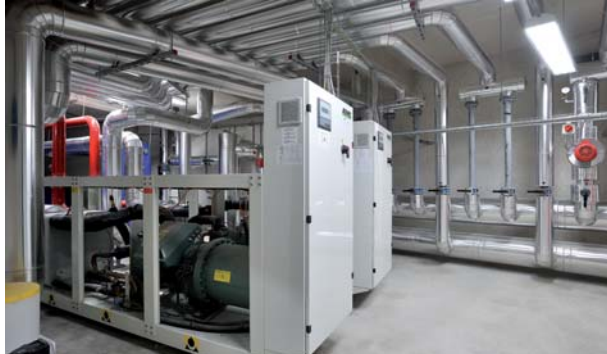
Gruppi frigoriferi a condensazione in acqua Water-cooled chillers
